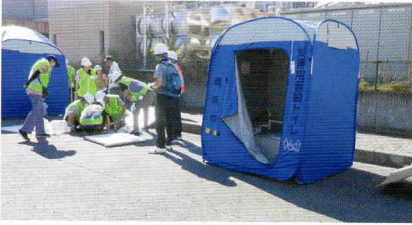
仮設トイレ設置
